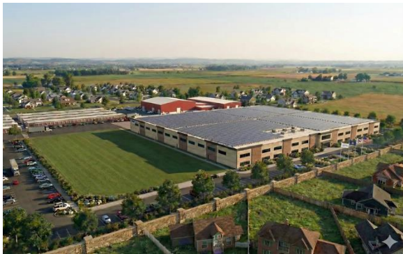
〈그림1〉LS ELECTRIC Utah 공장 증설 조감도
