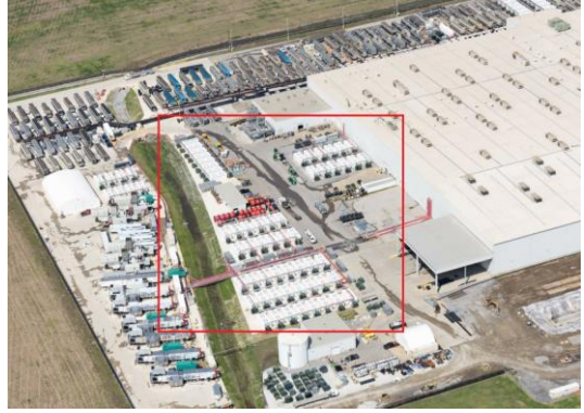
BESS와 데이터센터가 합쳐진 현장 모습
