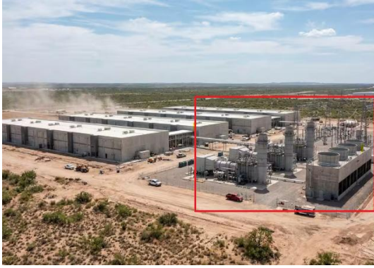
가스 발전과 데이터센터가 합쳐진 현장 모습
