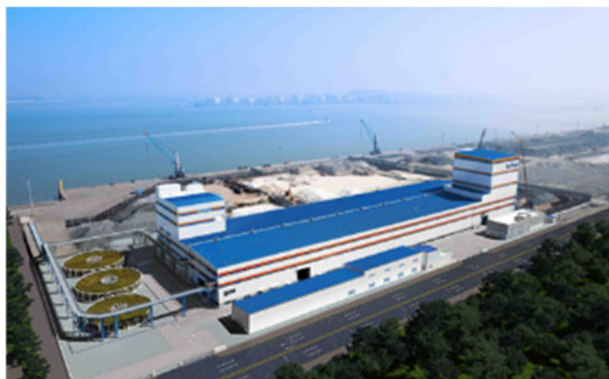
그림 270. 대한전선 당진해저케이블 1공장
