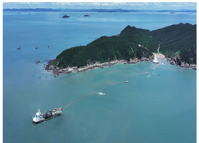
그림 263. 대한전선 낙월 해상풍력 외부망 포설 과정
