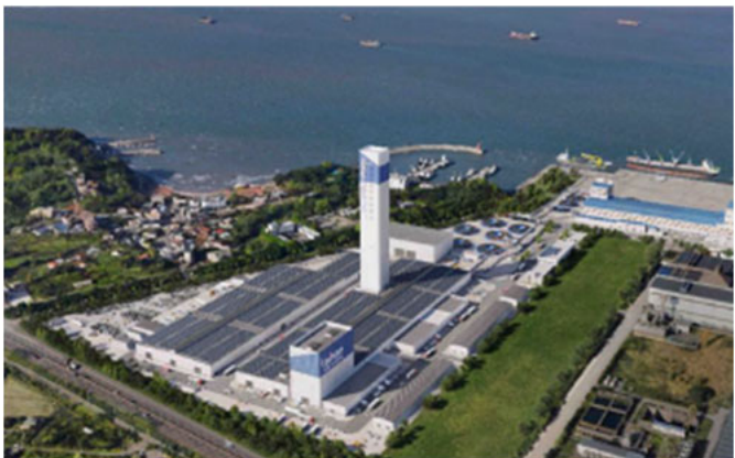
그림 271. 대한전선 당진해저케이블 2공장
