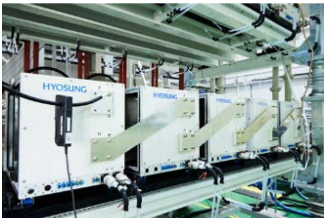
그림 163. 효성중공업 22.9kV SST
