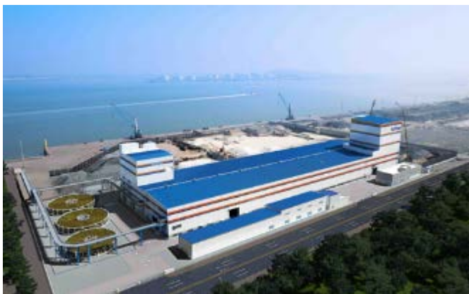
그림 270. 대한전선 당진해저케이블 1공장
