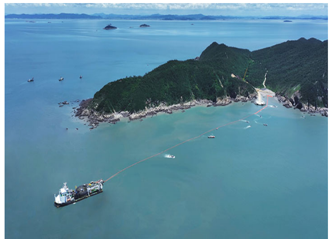
그림 263. 대한전선 낙월 해상풍력 외부망 포설 과정
