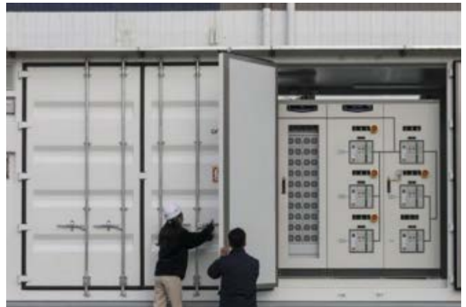
그림 215. LS일렉트릭 DC 팩토리 내 SST
