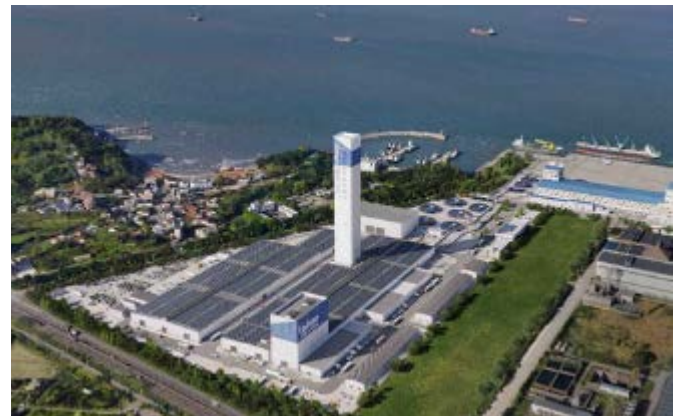
그림 271. 대한전선 당진해저케이블 2공장
