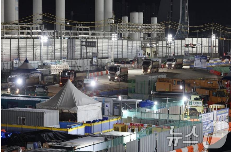
삼성전자 P5 공사 현장
