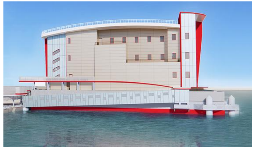
Keppel의 2세대 부유식 데이터센터, 2028년 상업운전 목표
