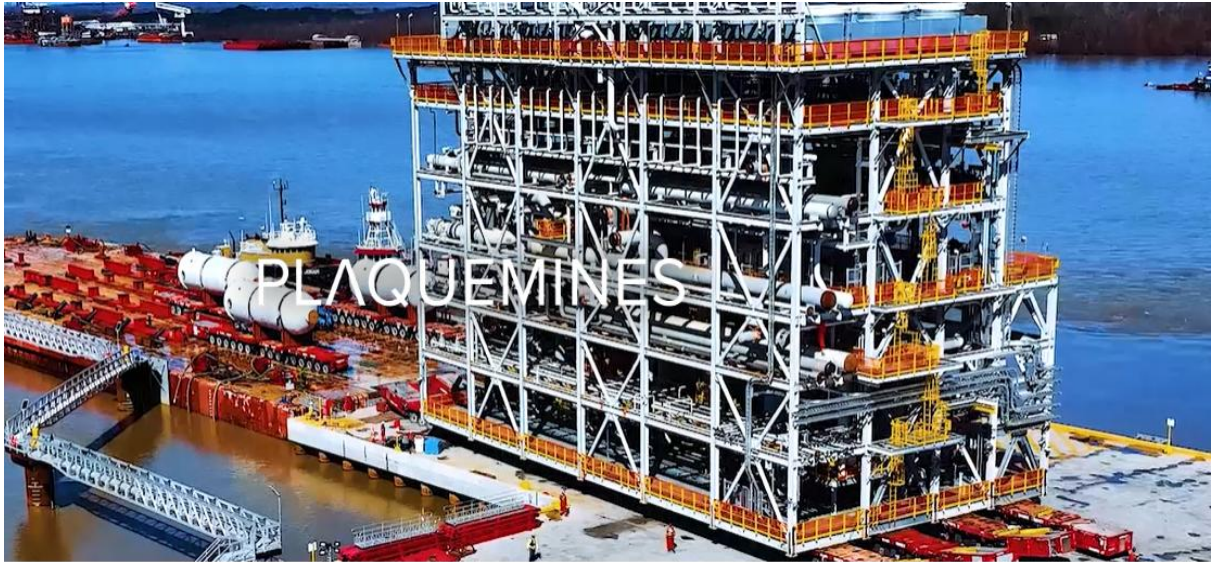
[도표 21] LNG 플랜트 모듈(플라크민 모듈)
